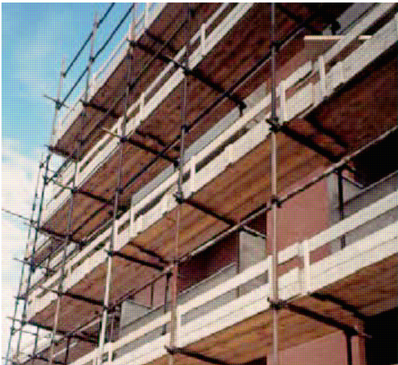
Ponteggio "tubo e giunto"
